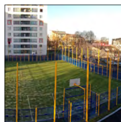
Pose auto-stable sur dalle d'étanchéité
