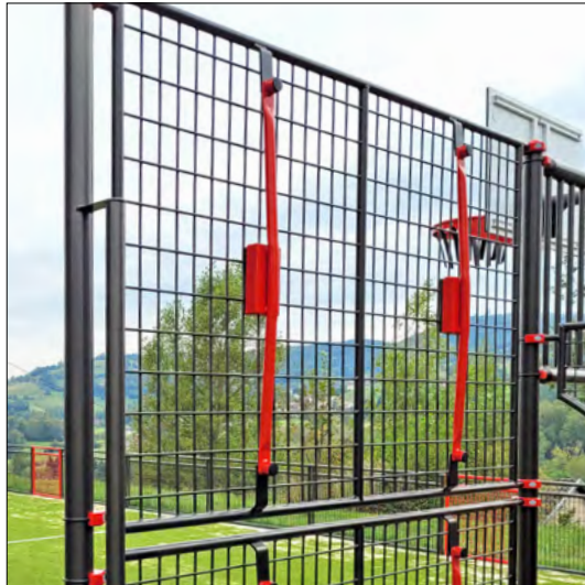
Amortisseur de bruits : Réduction de 2.5 dB à 1 m
