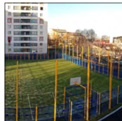
Pose auto-stable sur dalle d'étanchéité
