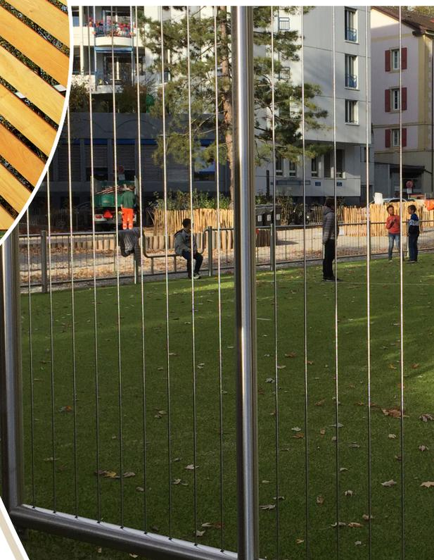
Afin de permettre la pose d'une couverture filet (de la surface de jeu), le Polysport est pourvu d'un poteau double de Ø 76 mm et de hauteur 500 cm. Les frontons, d'une hauteur de 300 cm sont complétés par un filet polyamide de 200 cm.
