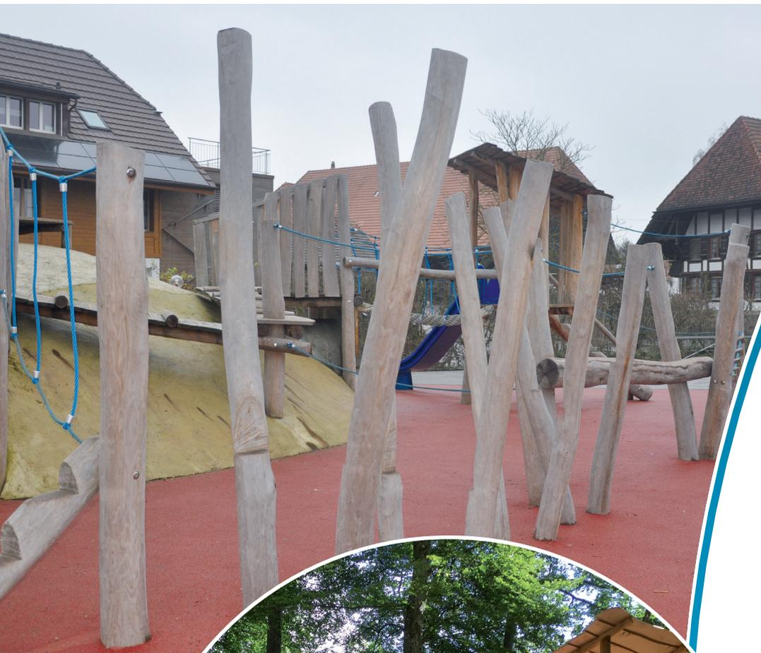
Le robinier est le bois européen le plus durable (classe 1 à 2). Il peut être mis en contact direct au sol et ne doit pas être traité. Une lasure incolore à pores ouverts est appliquée uniquement dans les cas où le grisaillement du bois n'est pas souhaité.
